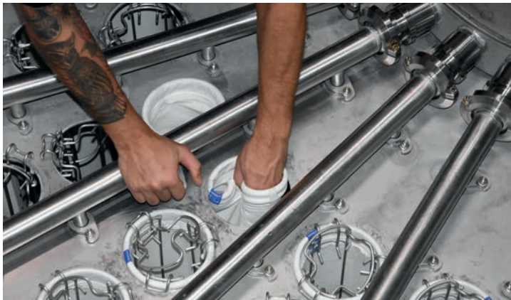
Afb. 2 Montage van filterzakken met snapring
