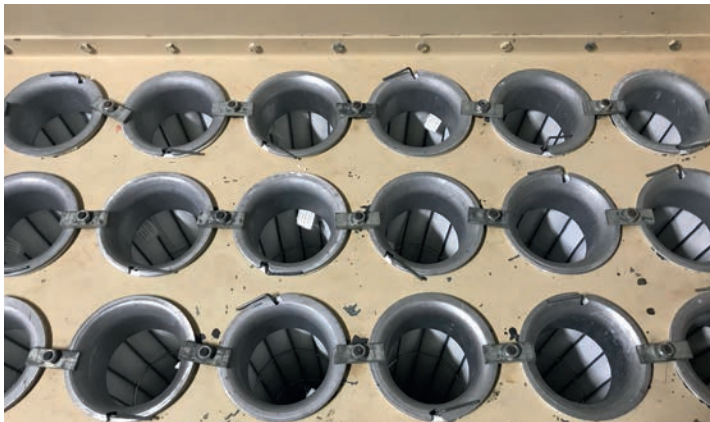
Afb. 3 Met kikkerplaat gemonteerde filterkorven
